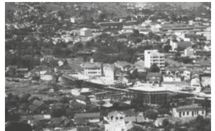
Construção do Viaduto de Madureira
