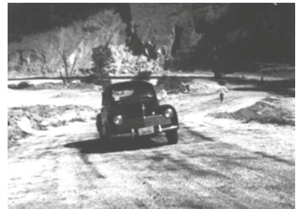
Construção da Rodovia Grajaú-Jacarepaguá
